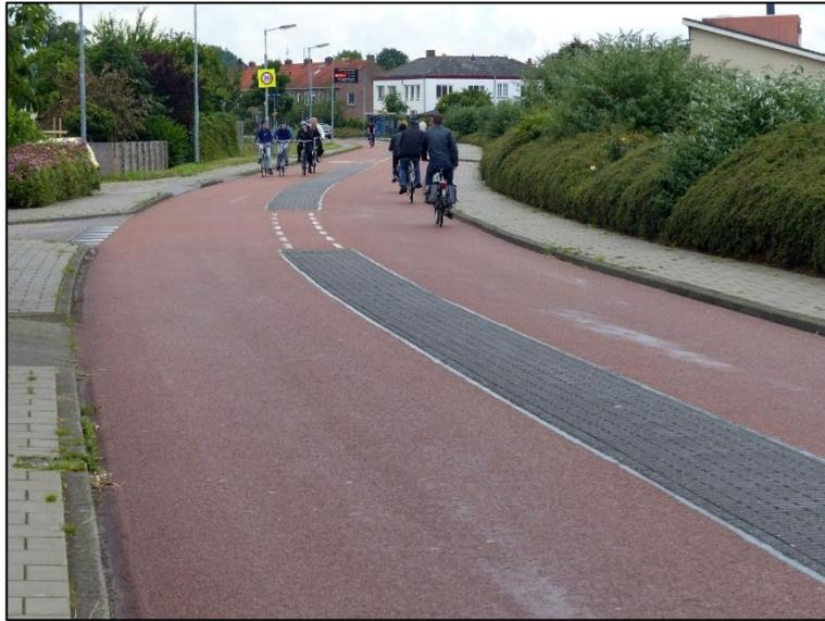
Abb. 1-2: Fahrradstraße mit gepflastertem Mittelstreifen in den Niederlanden
